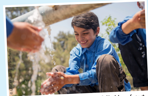
Afghanistan: Der 12-jährige Mir Haq freut sich über das saubere Wasser, das seit kurzem aus den neuen solarbetriebenen Wasserpumpen in seiner Schule fließt.
